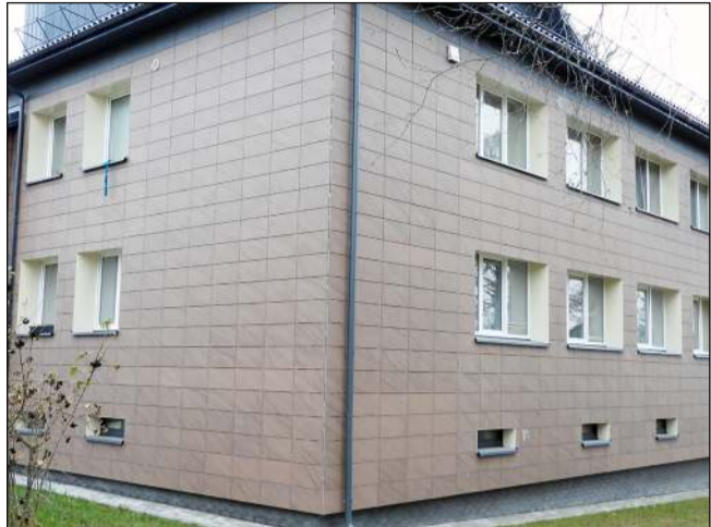
Pažangus sprendimas (Inturkės g. 49) – fasadui pasirinkta akmens masės plytelių apdaila
