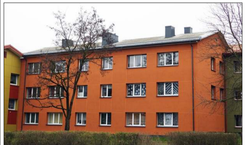
Gyventojų sprendimu Amatų gatvėje 8 numeriu pažymėto daugiabučio namo stogas liko dengtas asbestiniu šiferiu...
