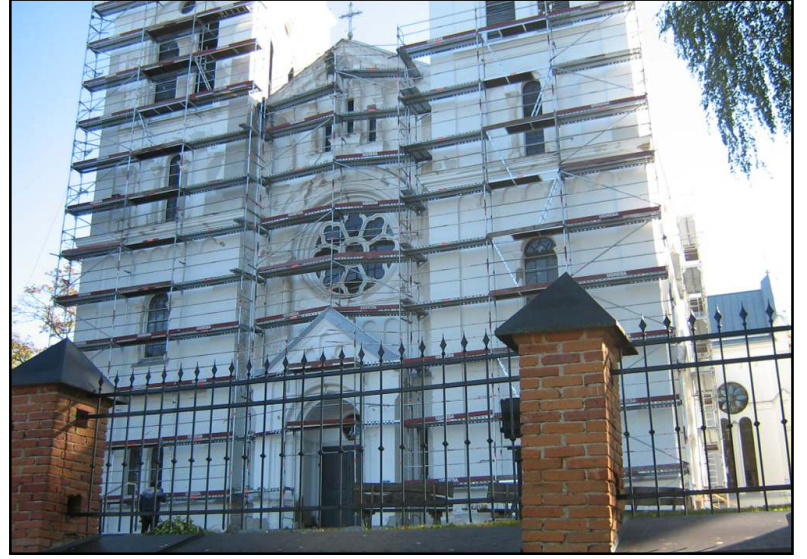
Alantos šv. Jokūbo bažnyčios fasadas dėl dažymo darbų "pasipuošė" pastoliais
