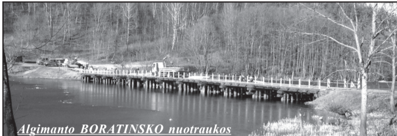
Kelininkai jau pakeitė pažeistas medinių polių viršutines dalis, šiuo metu keičiama medinė perdanga
